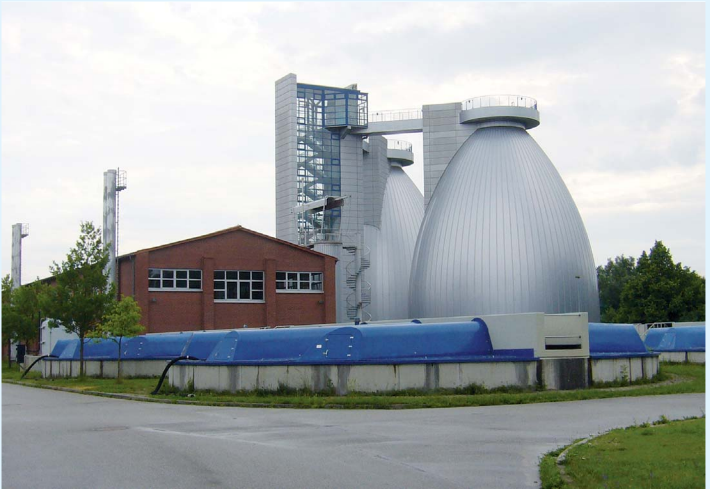
Faulbehälter der Kläranlage Landshut
