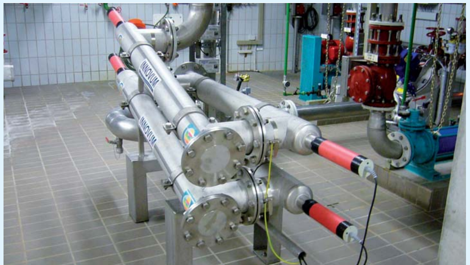
HOCHSPANNUNGS-DESINTEGRATIONSANLAGE: mit vier hintereinander geschalteten Elektroden
